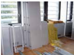
Zwischendurch: Die Wand-systeme und ihre Elektrifizierung werden systematisch demontiert.
